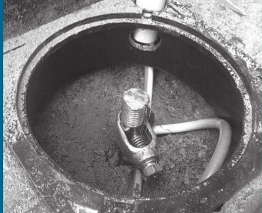
Detalle de las jabalinas de puesta a tierra de cobre, los accesorios de alargue y los accesorios de conexión.
